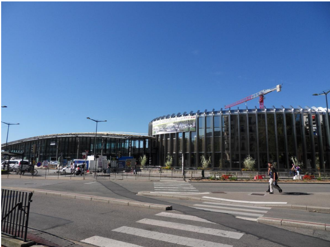
La gare d'Annecy, devenue pôle d'échange multimodal, a été pensée pour être en tout point accessible aux personnes à mobilité réduite. (© KLB Group)
